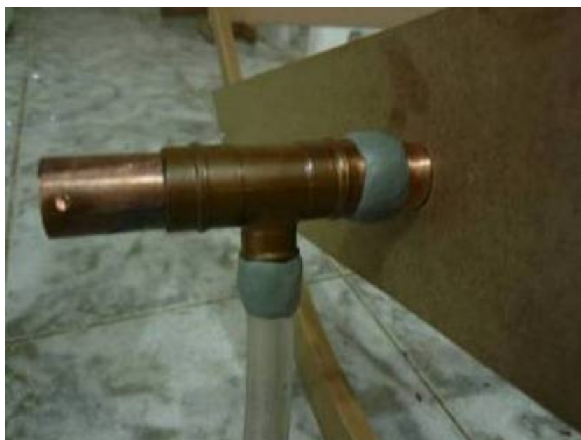
Fig.14. 16 – TE de redução com vedação de durepoxi.
