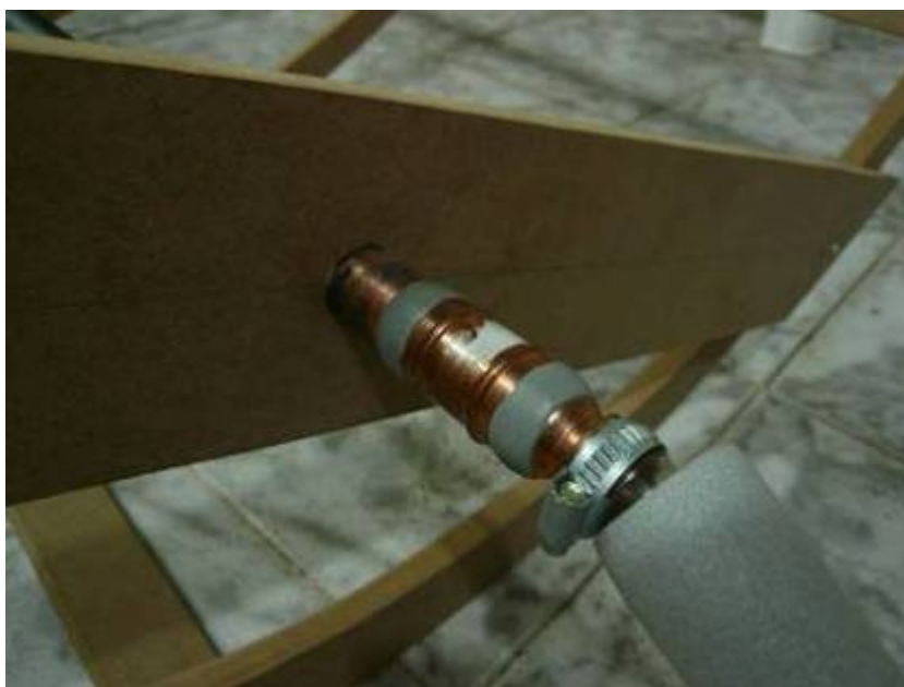
Fig.14. 17 – Bucha de redução e luva passante com vedação de durepoxi.
