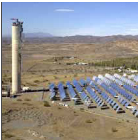
Fig. 6. 2 – Instalações de torre de energia no sul da Espanha.
